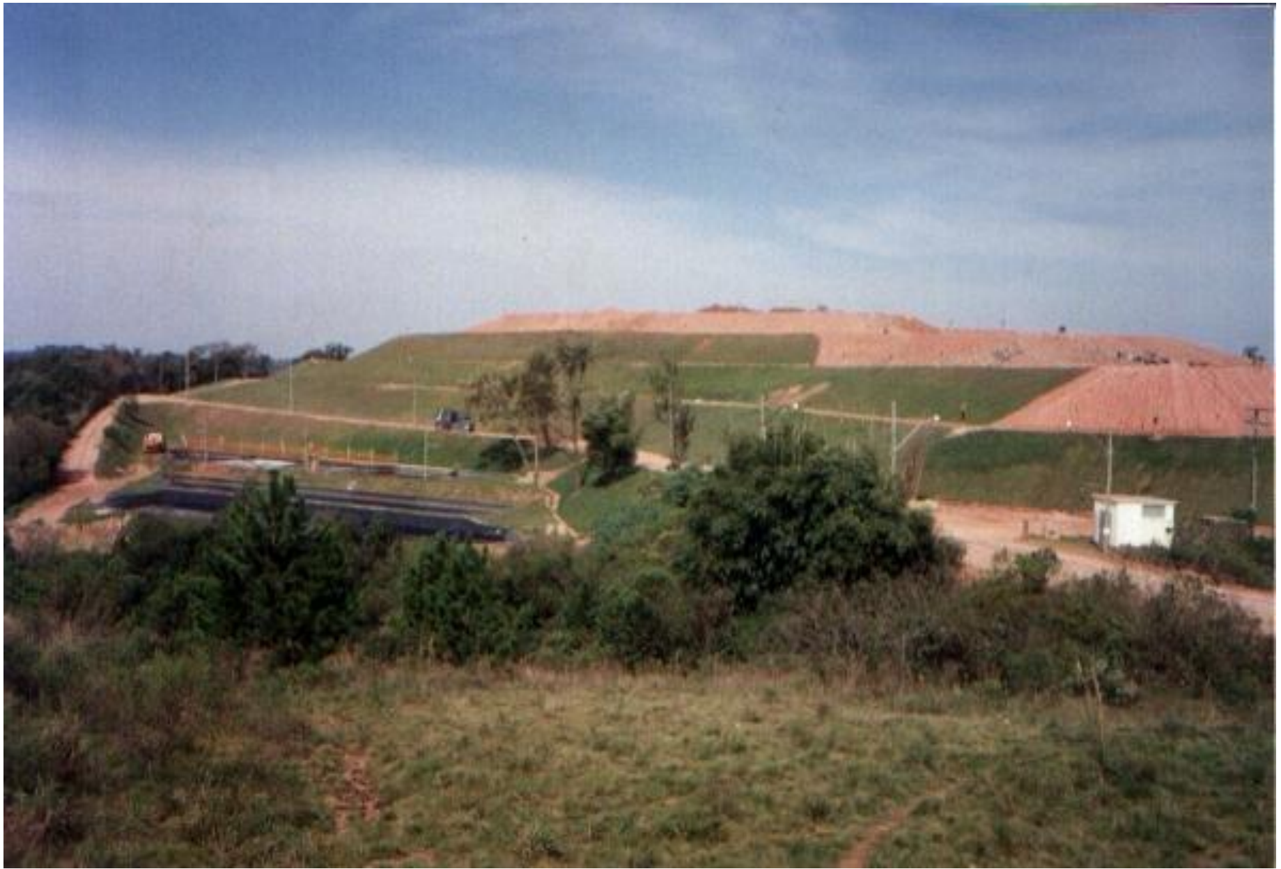
Aterro Santa Tecla – Gravataí - RS
